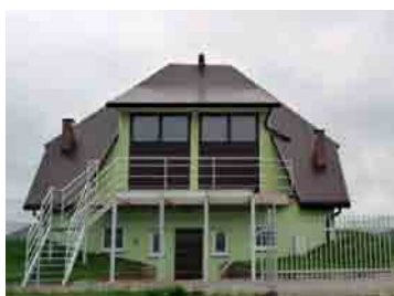
Stacja Uzdatniania wody
