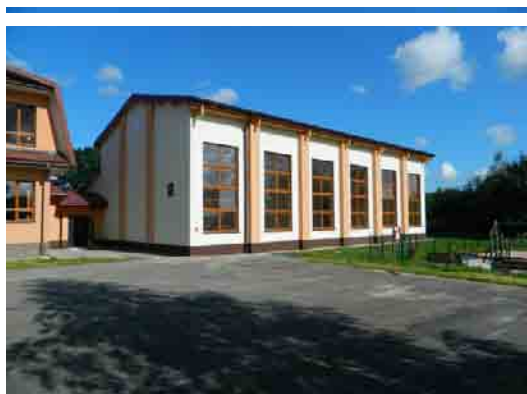
Budowa sali gimnastycznej w Żbikowicach;
