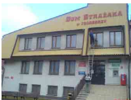
Remont dachu Domu Strażaka Tęgoborzy;
