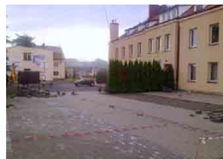
Remont budynku oraz wykonanie parkingu przy SPZOZ w Łososinie Dolnej; /Malowanie dachu SPZOZ w Tęgoborzy;
