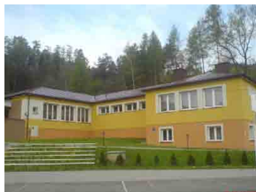
Pomalowano dach SP w Witowicach Dolnych
