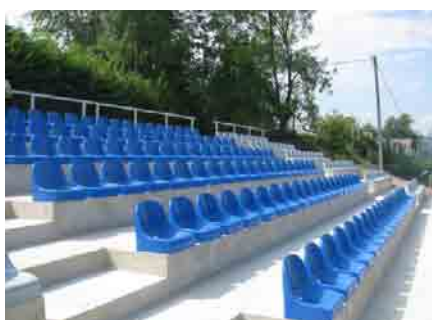
Trybuny stadionu sportowego LKS „Victoria” w Witowicach Dolnych;
